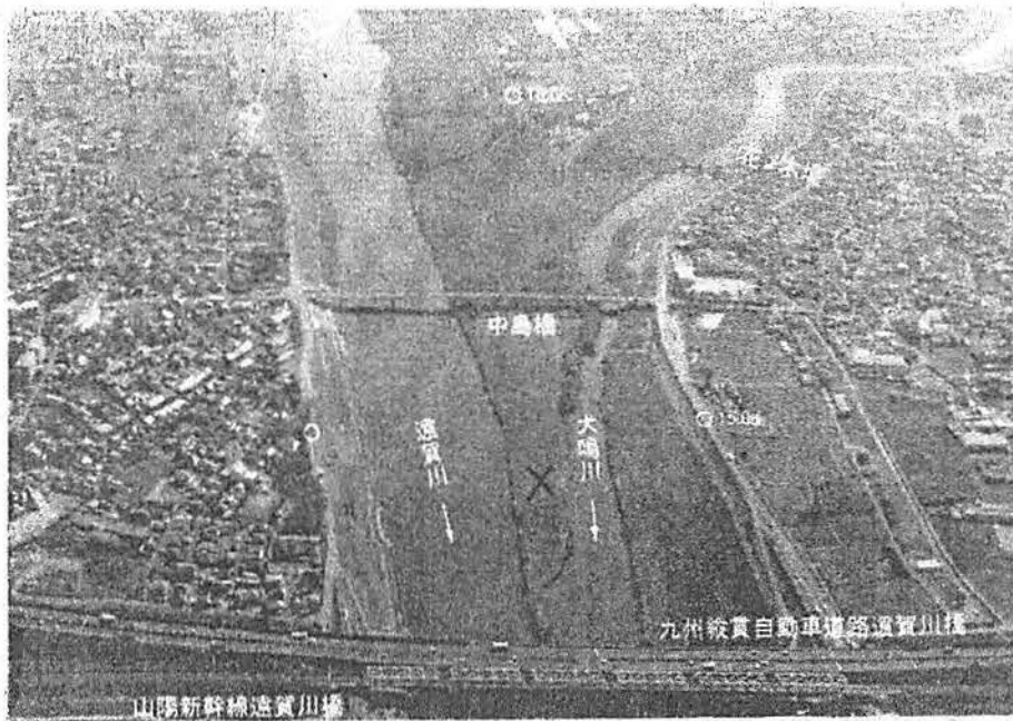
墜落現場を北から見る ×が墜落地点(国土交通省遠賀川事務所提供)
